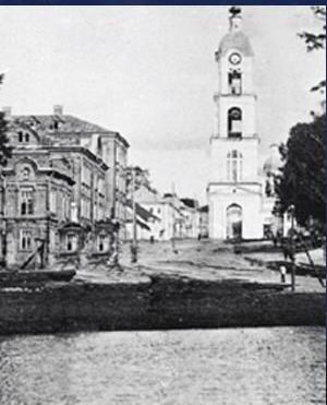
Красный дом, в котором работали руководство и теоретики КБ-11. Саров, начало 1950-х годов
