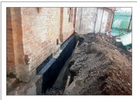
Фото 7. Устранение неисправностей гидроизоляции стен фундаментов южного фасада
