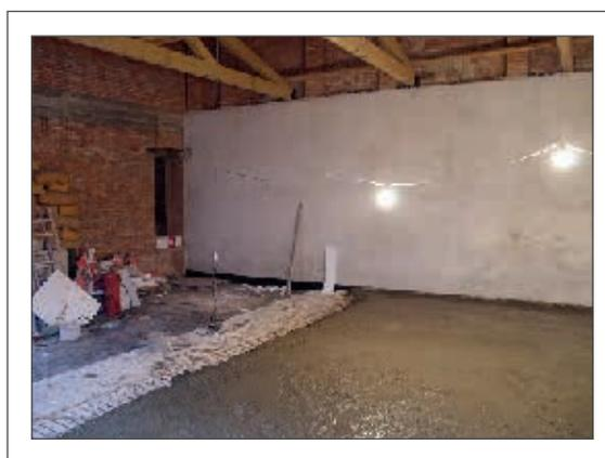
Фото 10. Бетонирование полов
