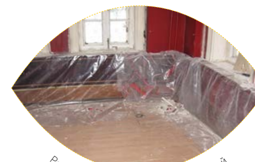
Ремонтные работы в «Красной» гостиной
