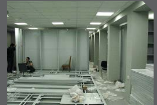
► Монтаж металлических стеллажей
