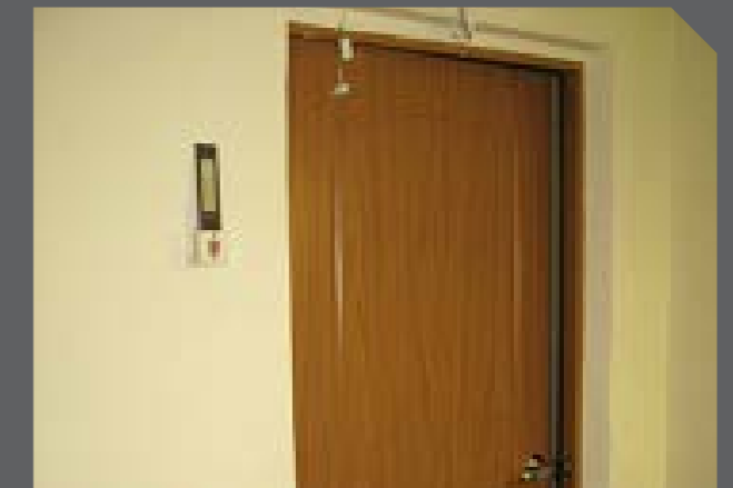
► Замененная дверь в подвале дома № 27
