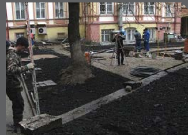
► Внутренний двор музея работы по благоустройству
