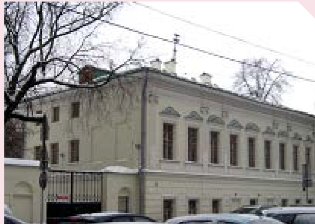
► Общий вид дома №29 с ул. Бахрушина
