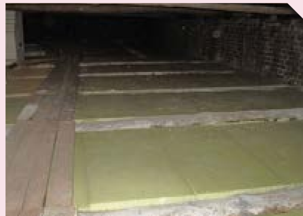
► Дом №29. Состояние перекрытия чердака после реставрации
