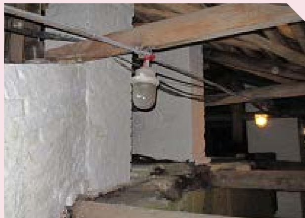
► Дом №29. Состояние печных труб после реставрации
