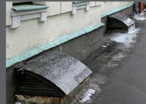
► Вид приямков со стороны ул. Бахрушина
