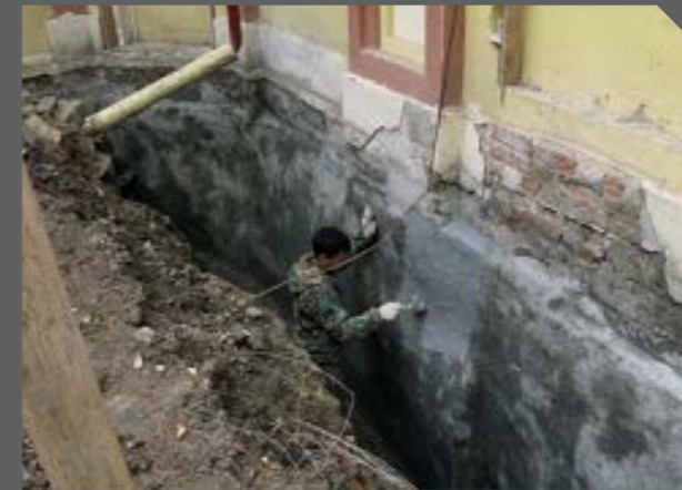
► Устройство гидроизоляции стен и фундамента
