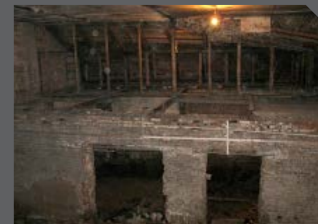
► Проведение противоаварийных работ
