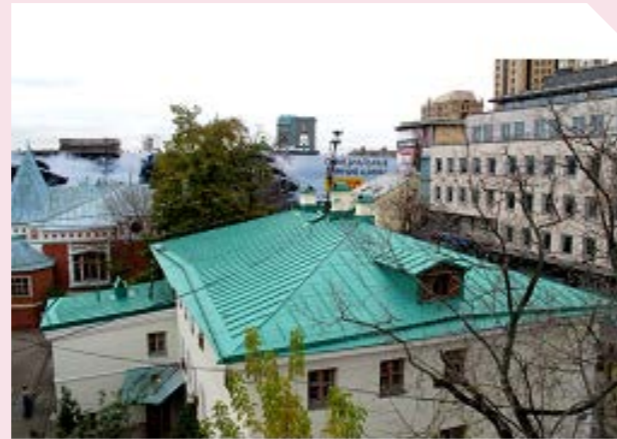
► Общий вид крыши дома №29
