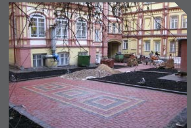
► Внутренний двор музея работы по благоустройству
