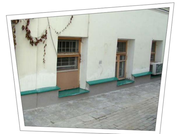
Фото 11. Восстановление отмостки после проведенных работ по гидроизоляции д. 29
