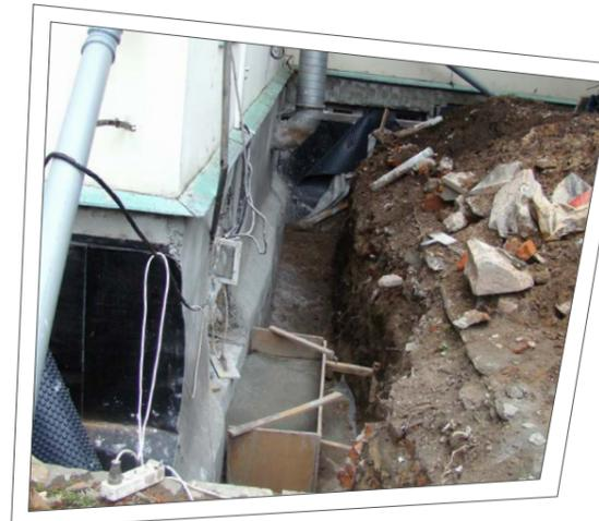
Фото 8. Устройство оклеечной гидроизоляции д. 27
