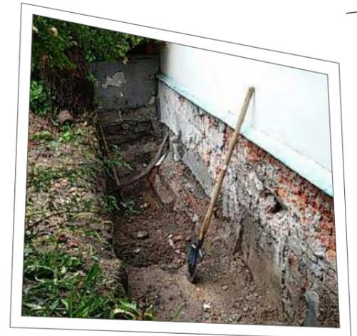
Фото 7. Устройство гидроизоляции стены д. 27
